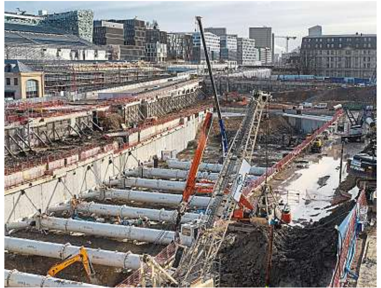
Photo panoramique du chantier en janvier 2024. M. Fourmy / Sipa
